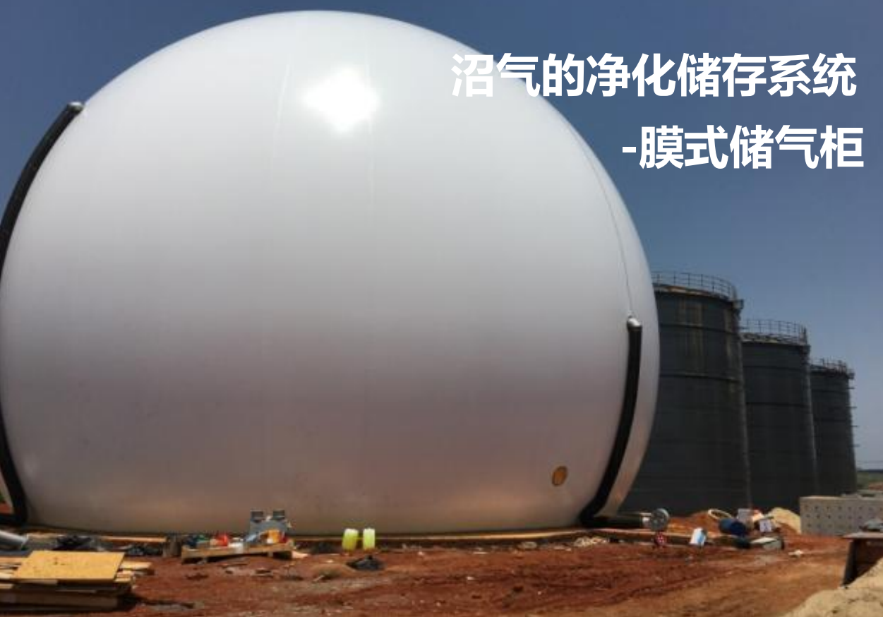
▲ 江苏海安2MW. 鸡粪+水稻秸秆沼气发电项目 4000方落地膜式储气柜
