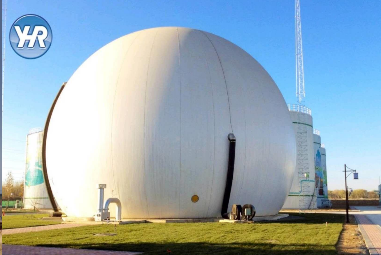
▲ 河北三河天龙3.3万方生物天然气项目. 5000方落地膜式储气柜
